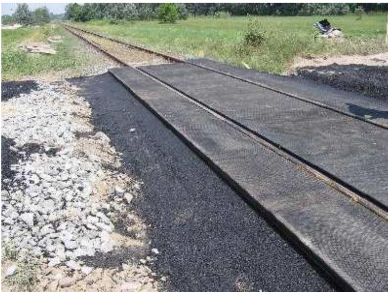
Elkészülte után a csatlakozó közúti aszfalt burkolat az elhelyezett „Strail” elemekkel közvetlenül összeilleszthető.
