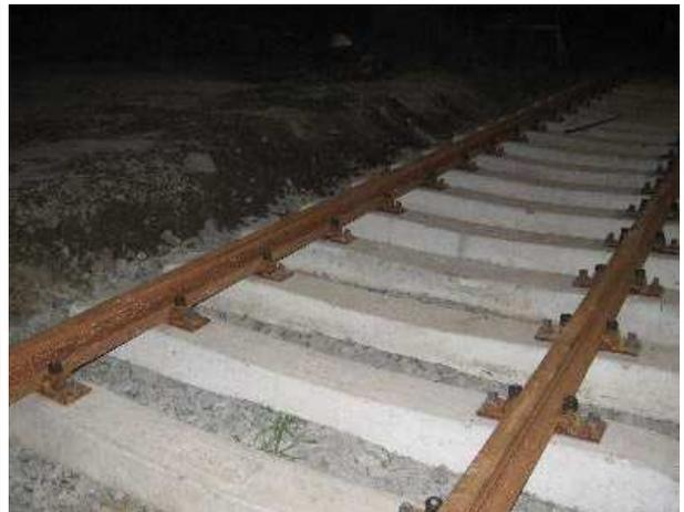
Az összeszerelés befejezése, felsőágyazat behordása a vágányba,
