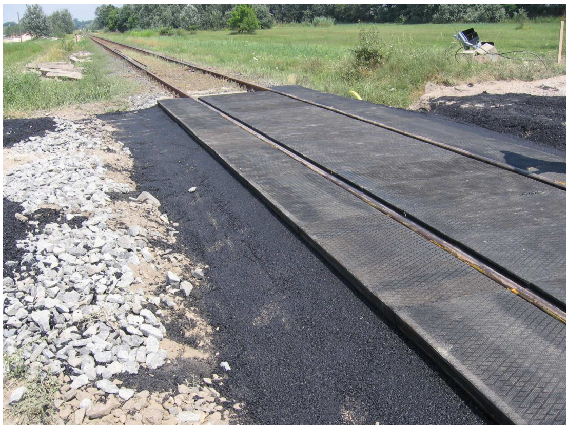
Az elkészült „STRAIL” burkolatú útátjáró, a csatlakozó útszakasz megépítése előtt.
